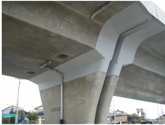
京都第二環状道路 長岡高架橋(京都府)
